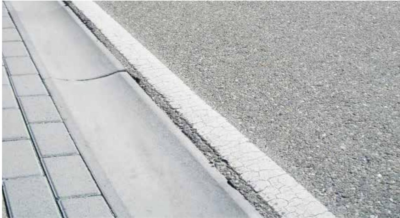
Les caniveaux CC sont des caniveaux à double pente destinés à la récupération des eaux pluviales en traversées de chaussées ou en zones de stationnement.
